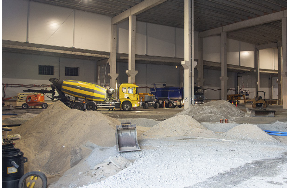
W zakładzie produkcji zespołów napędowych było ok. 20 pracowników budowlanych, ale liczba ta zmieniała się w zależności od etapu budowy.
